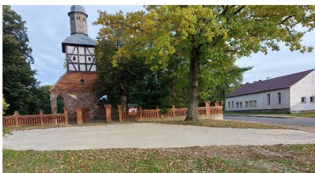
Utwardzenie placu przy kościele w Wojcieszycach
