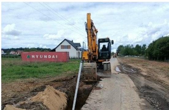
Budowa kanalizacji sanitarnej w Chwałęcicach
