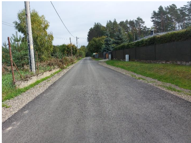
Remont nawierzchni na ulicy Leśnej w Santocku
