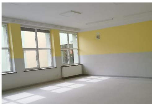
Remont gabinetów lekcyjnych w SP Kłodawa
