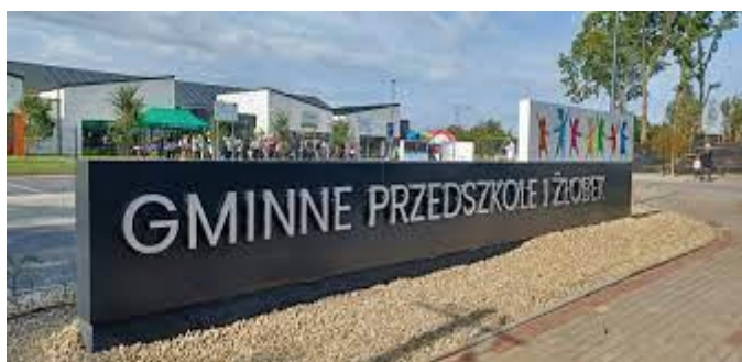
Budowa gminnego przedszkola i żłobka w Kłodawie
