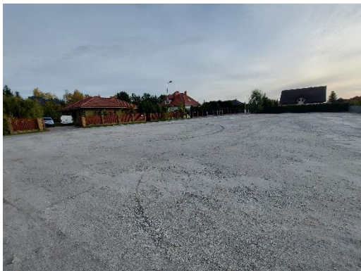
Utwardzenie placu parkingowego przy SP Kłodawa
