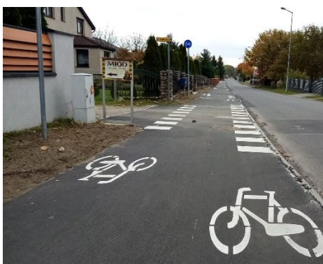
Budowa ścieżki rowerowej Mironice – Santocko
