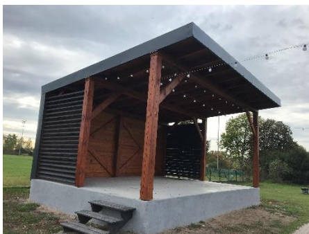
Budowa wiaty w Wojcieszycach
