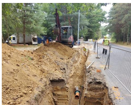
Budowa kanalizacji w Santocku
