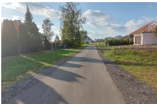
Remont ul. Jaśminowej w Chwałęcicach
