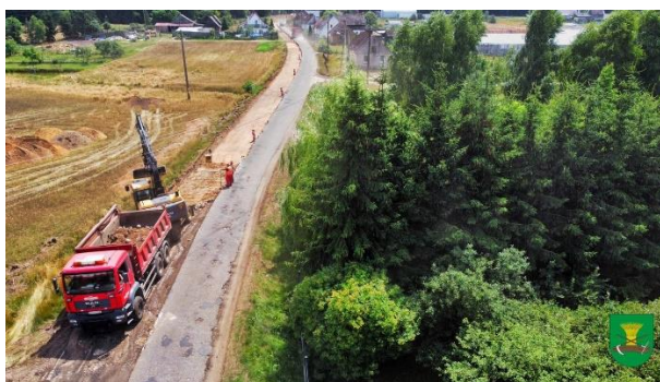
Przebudowa drogi powiatowej w Łośnie
